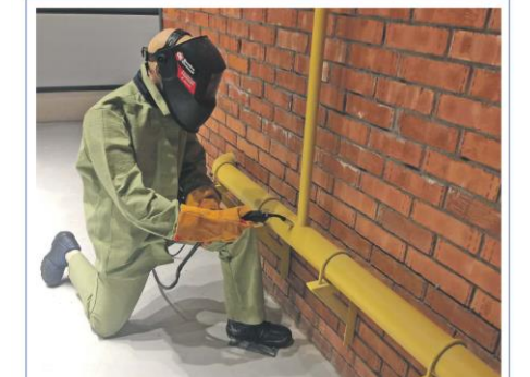
Взгляд под Санкт-Петербургом на учебный базис СПО АСУ. Фото: Александр Попов. Нижний курс, последний этаж. Фотографировать и снимать труд на строительных площадках.
