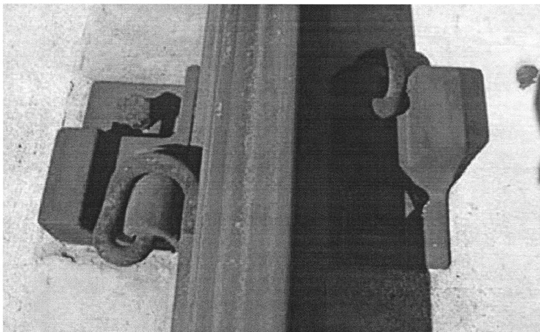
Рисунок 17 – Безрезьбовое упругое нераздельное рельсовое крепление с одновитковыми торсионными клеммами для железобетонных шпал
