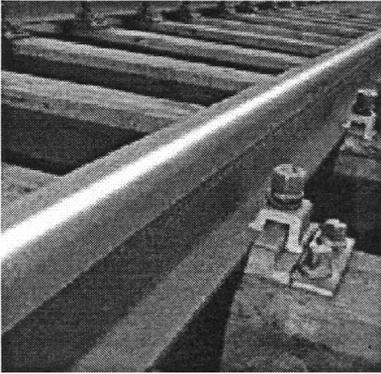
Рисунок 10 – Жесткое раздельное рельсовое крепление для деревянных шпал
