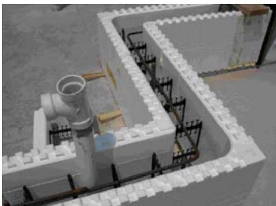
Рис. 1. Сборная опалубка из пенополиуретана для секций стен, собранная на строительной площадке
