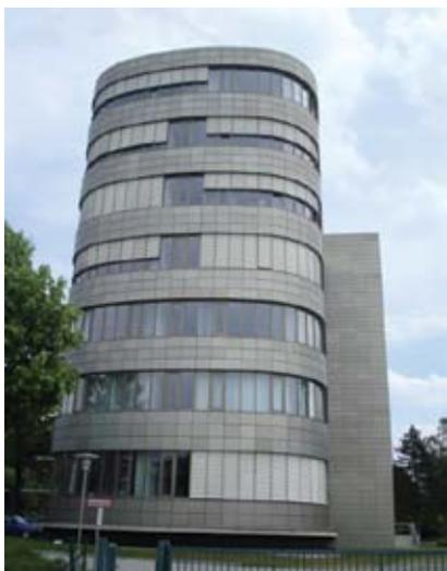
Рис. 3. Пример рольставней, установленных на офисном здании (г. Дармштадт, Германия)
