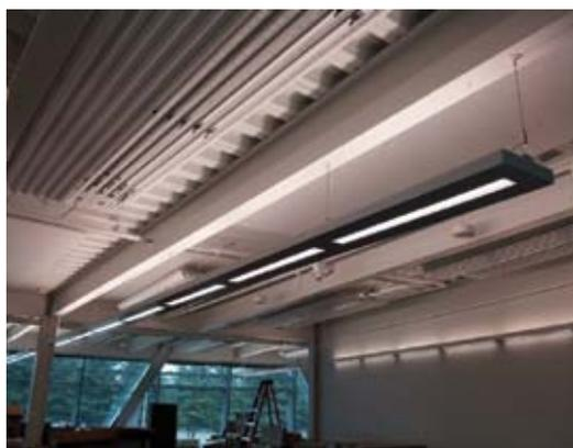
Рис. 2. Общее освещение помещения с использованием отражающих поверхностей (офисное здание в Сиэтле, штат Вашингтон)
