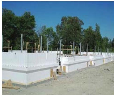
Рис. 2. Новый офис фирмы Rayalton Homes с подземной частью стены, выполненной с использованием стандартной технологии ICF
