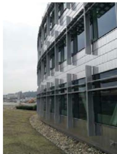
Рис. 3. Вертикальные солнцезащитные ребра на здании офиса в г. Сиэтл (США)
