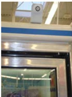
Рис. 2. Датчик движения
