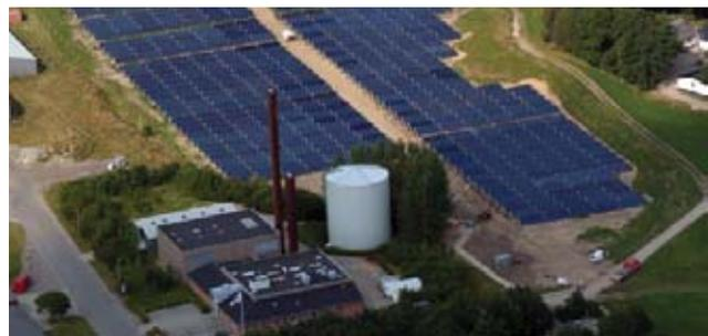
Рис. 4. Центральная котельная в г. Бредstrup (Дания) с присоединенной системой плоских панельных солнечных коллекторов
