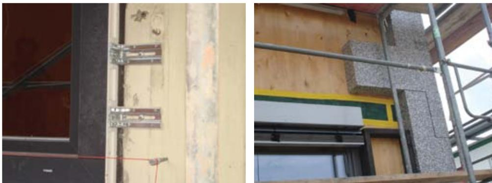
Рис. 6. Для предотвращения тепловых мостов при установке окон использовались кронштейны в пределах слоя наружной теплоизоляции
