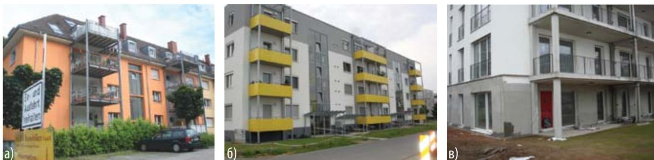
Рис. 4. Пример реконструкции зданий в Германии с применением внешних подпорок балконов для устранения тепловых мостов: а и б — металлических колонн, в — железобетонных колонн
