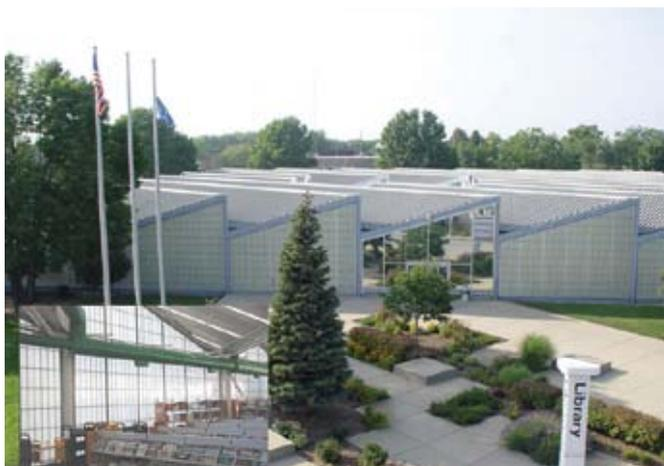
Рис. 1. Ремонт здания с применением прозрачных стен системы KalWall. Общественная библиотека, г. Мичиган Сити, Мичиган Сити, Индиана (США). Архитектор: Хельмут Ян
