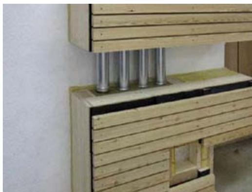
Рис. 3. Элементы фасада со встроенными телескопически соединяемыми воздуховодами. [www.empa-ren.ch/A50.htm](http://www.empa-ren.ch/A50.htm)
