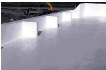
Рис. 1. Отражающее жидкостное покрытие кровли
