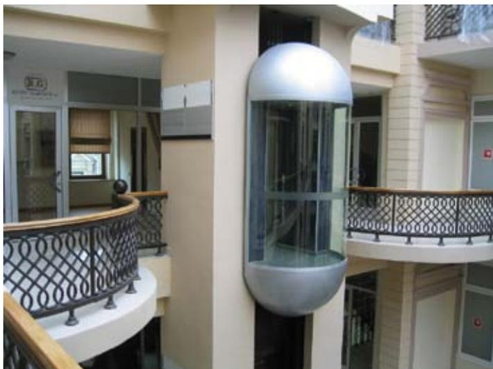
Рис. 1. Панорамный лифт. Вариант 1
