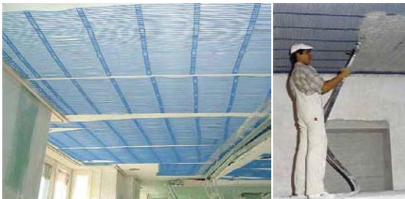
Рис. 1. Крепление отопительных и охлаждающих матов непосредственно к поверхности потолка
