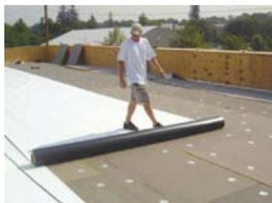
Рис. 2. Отражающая мембрана крыши
