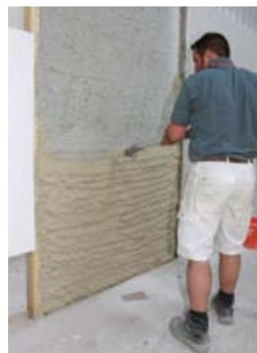
Рис. 2. Установка аэрогельной теплоизоляции
