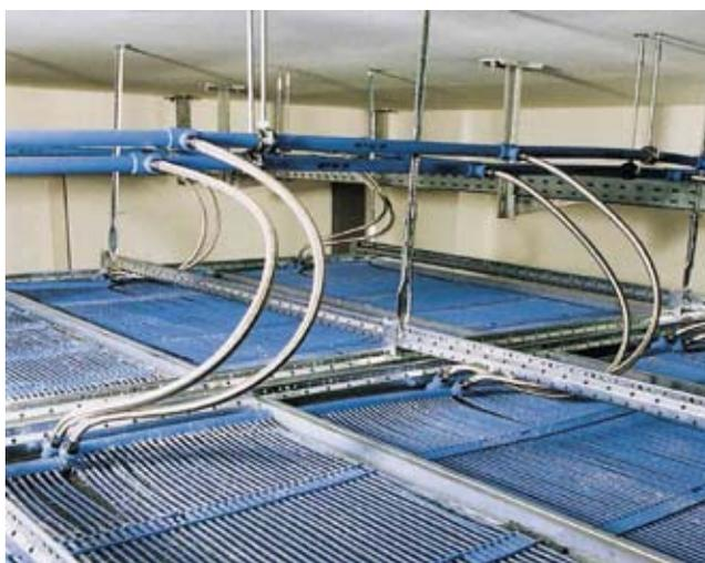
Рис. 2. Отопительные и охлаждающие маты, установленные на панелях подвесного потолка
