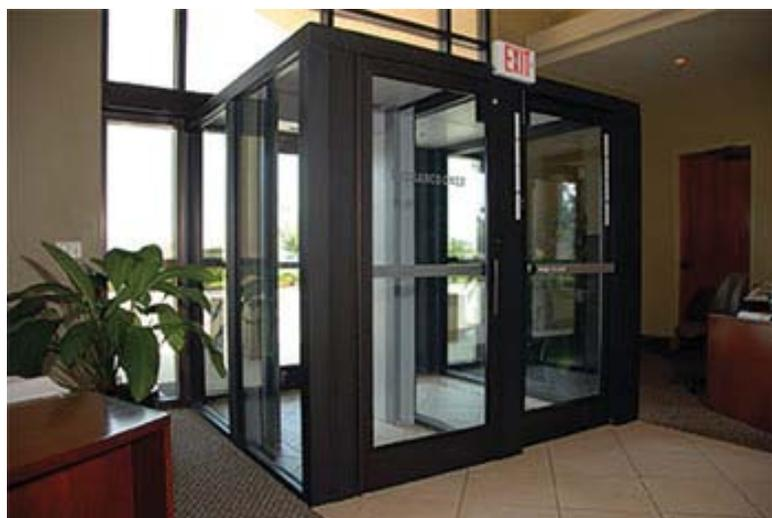
Рис. 3. Пример типичного тамбура, изготовленного в заводских условиях и смонтированного на входе в офисное здание
