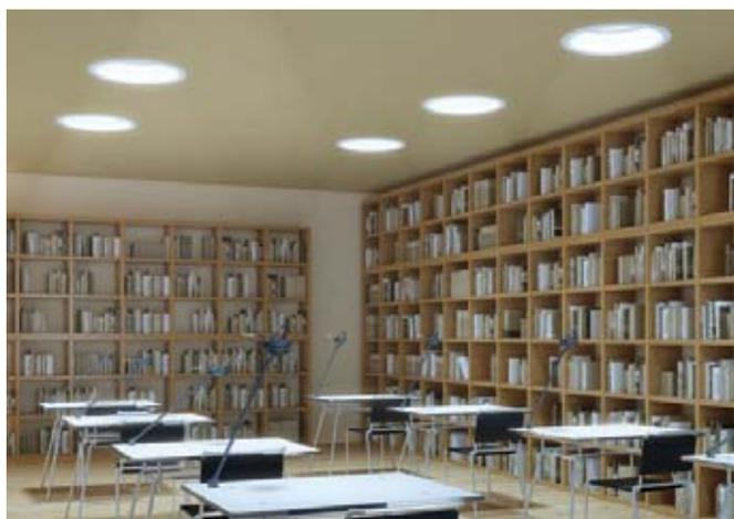
Рис. 2. Световая труба Sun Dome, установленная в здании школы. <http://www.castledaylighting.com/commercial.html>
