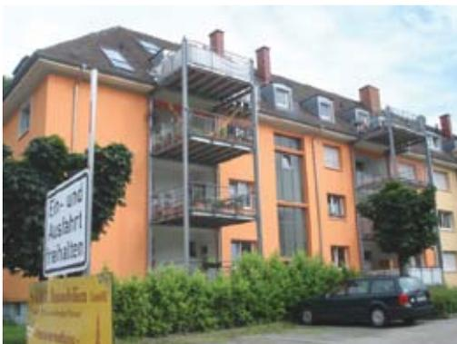
Рис. 4. Пример реконструкции зданий с применением внешних подпорок балконов для устранения тепловых мостов
