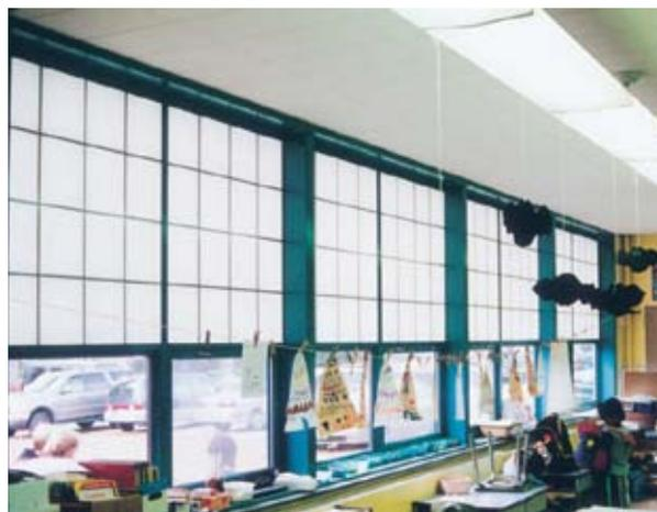
Рис. 2. Замена окон с использованием системы KalWall. Начальная школа Аллена. Рочестер, Нью-Хэмпшир (США)
