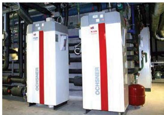
Рис. 2. Тепловой насос OCHSNER для нагрева воды до температуры 55 °C
