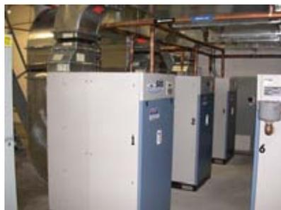
Рис. 2. Винтовой медицинский компрессор Powerex SOS
