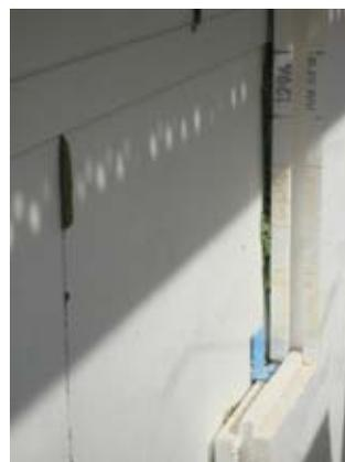
Рис. 4. Процесс теплоизоляции стены с применением вакуумных панелей и жестких панелей пенополиуретана
