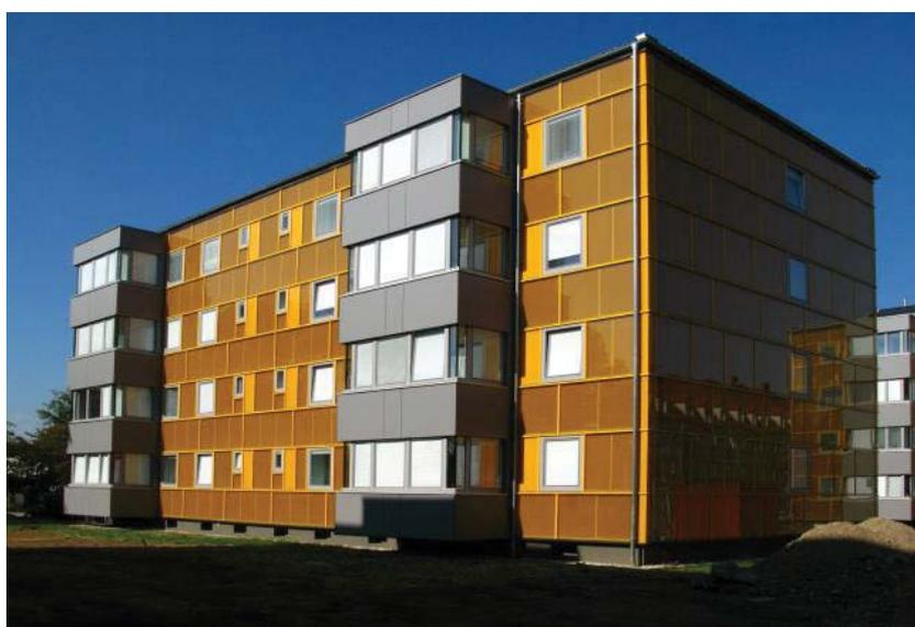
Рис. 5. После реконструкции жилого здания в г. Грац (Австрия) балконы застеклены и расположены в пределах теплового барьера оболочки здания
