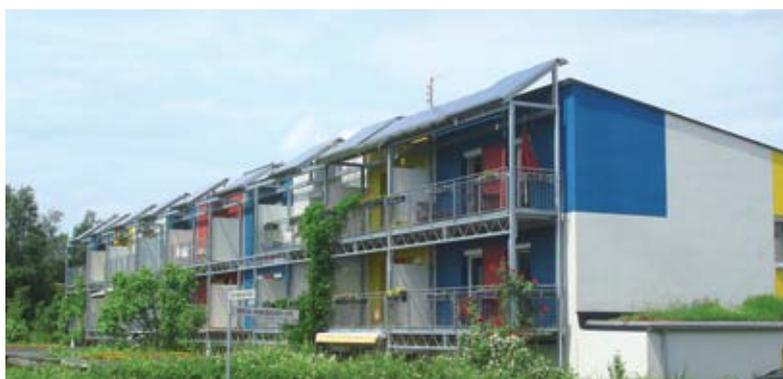
Рис. 2. Балконы и солнечные панели используются в качестве козырьков для защиты окон от попадания солнечных лучей. Пассивный дом в г. Дармштадт (Германия)
