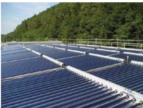
Рис. 3. Солнечные панели с вакуумными трубами, установленными на крыше Ритер Спорт (г. Вальденбах, Германия)
