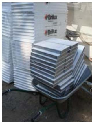
Рис. 3. Вакуумные панели и жесткие панели из пенополиуретана, подготовленные для монтажа на строительной площадке
