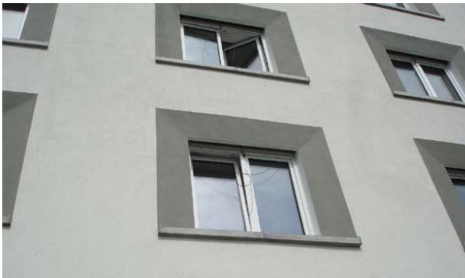
Рис. 5. Установка окна во внешнем слое теплоизоляции на расстоянии от плоскости фасада создает хорошее его затенение. Жилой дом в г. Франкфурт-на-Майне (Германия)
