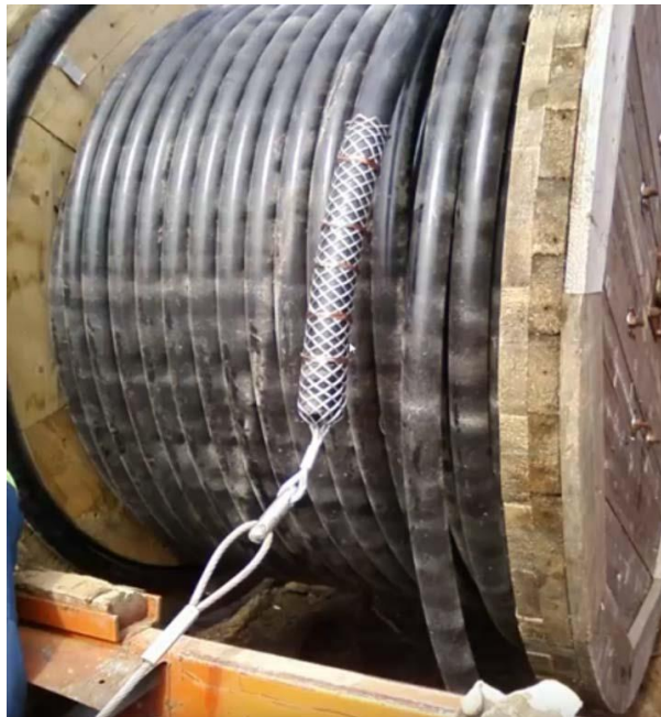
Рисунок 1 – Протяжка кабеля с использованием кабельного чулка
