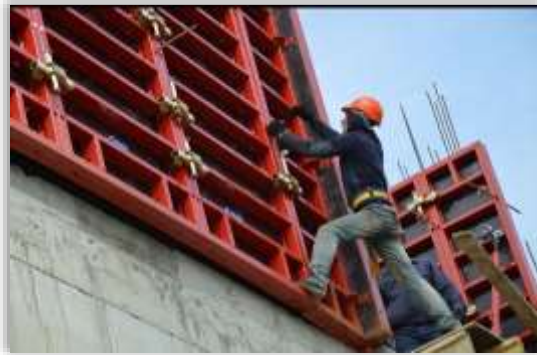
Монтаж и демонтаж опалубки монолитных железобетонных конструкций
