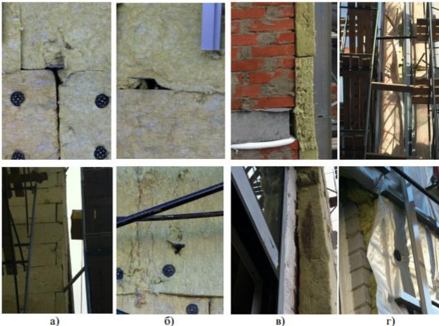
Рисунок 2.3 – Нарушение технологии устройства теплоизоляционного слоя: а) зазор в стыке плит утеплителя; б) зазор в стыке кронштейна с плитой утеплителя; в) отслоение теплоизоляционного слоя от основания; г) нарушение устройства ветро- гидроизоляционной мембраны
