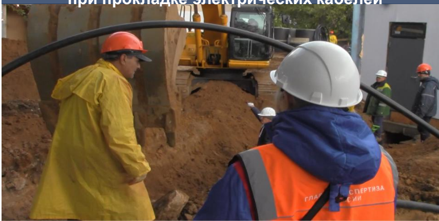
Гофрированные трубы ПВХ и сигнальная лента при прокладке электрических кабелей
