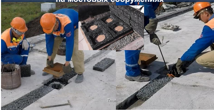
Дренажная система из брикетов на мостовых сооружениях
