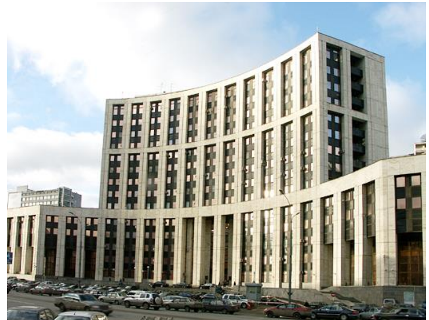
Здание Внешэконом банка, г. Москва
